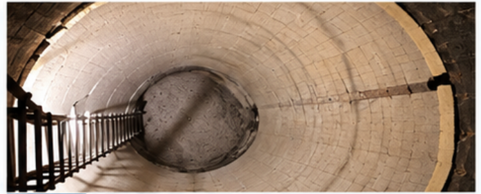
04 유동상 소각로 내화물 설치
