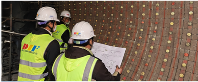
03 스토커 소각로 내화물 설치
