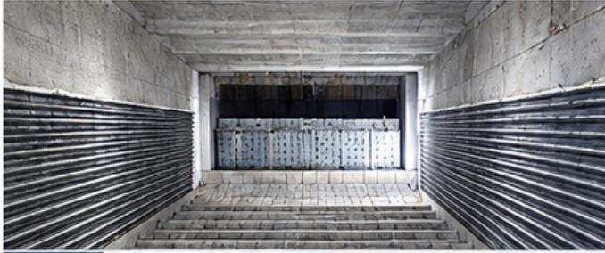
01 화력발전소 내화물 설치
